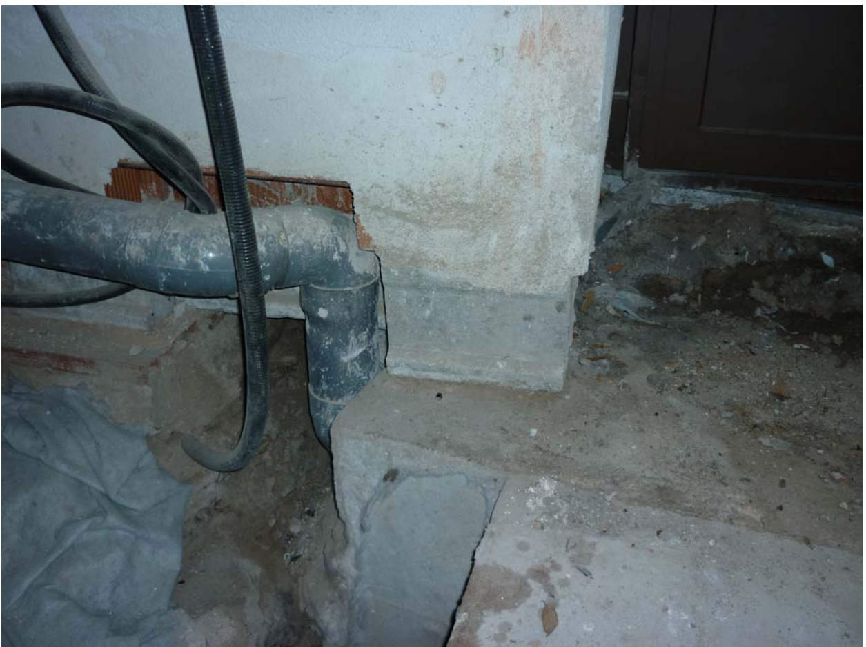
Estado actual del inmueble. Acometidas de saneamiento y bajantes existentes.
