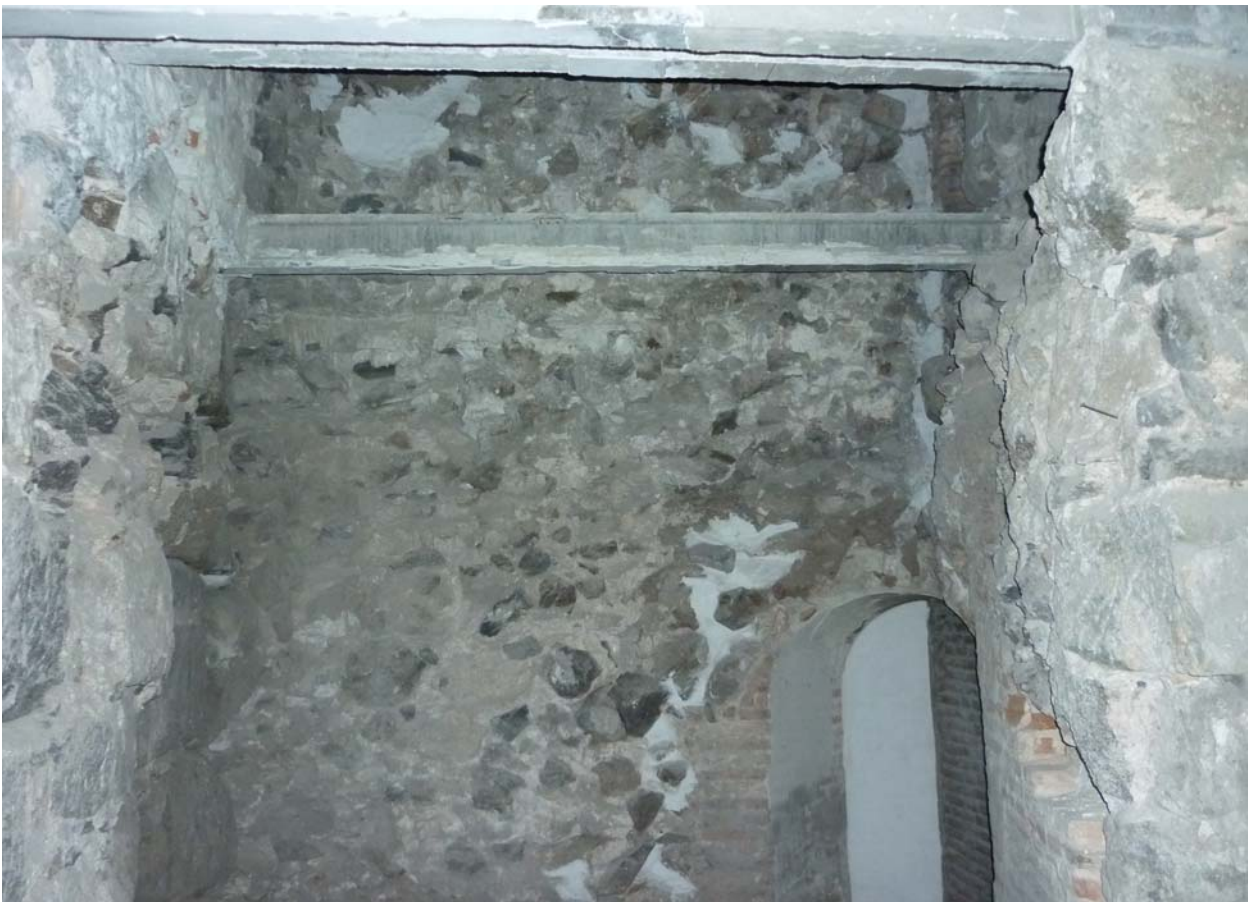
Estado actual del inmueble. Interior al fondo.
