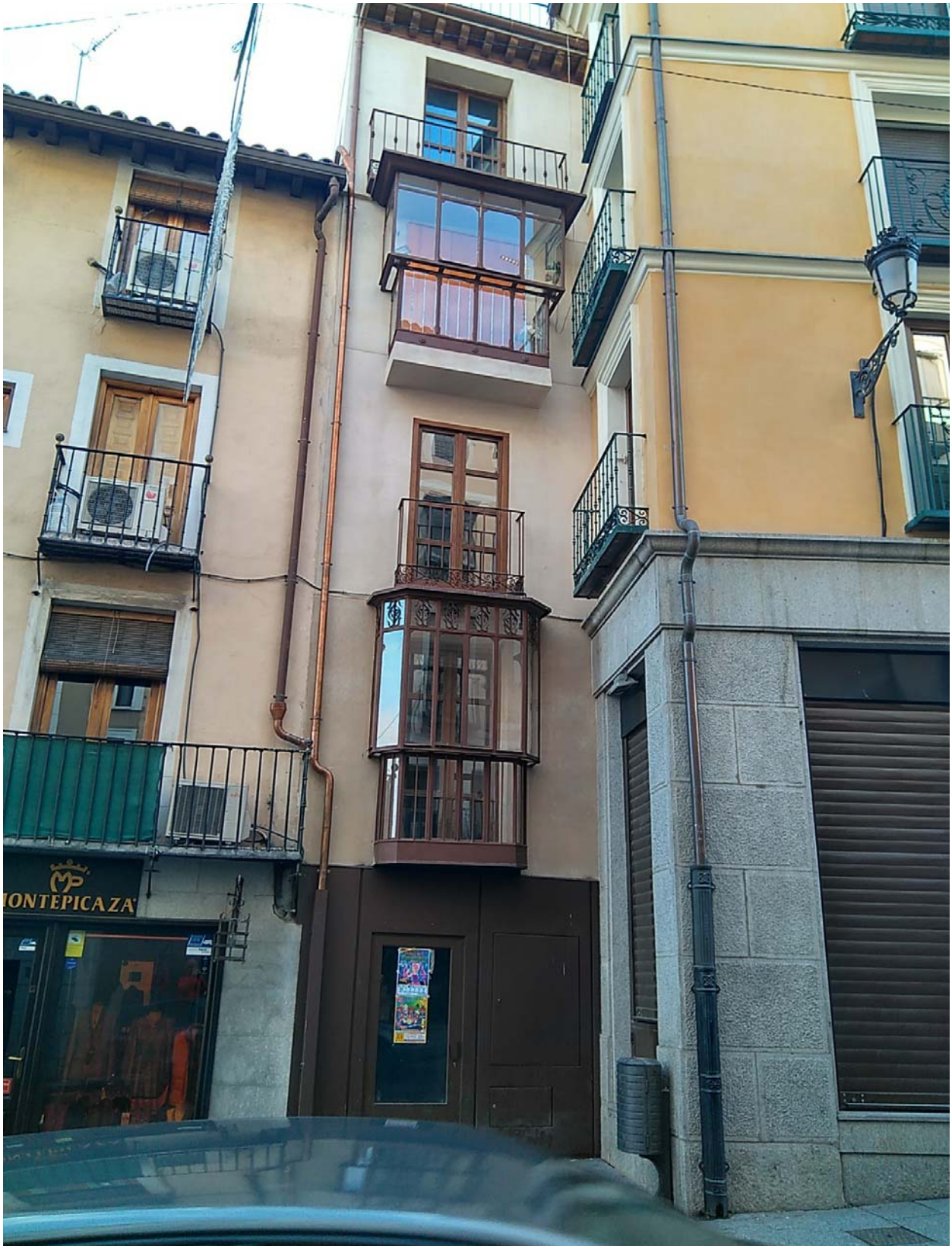
Estado actual del inmueble. Fachada.
