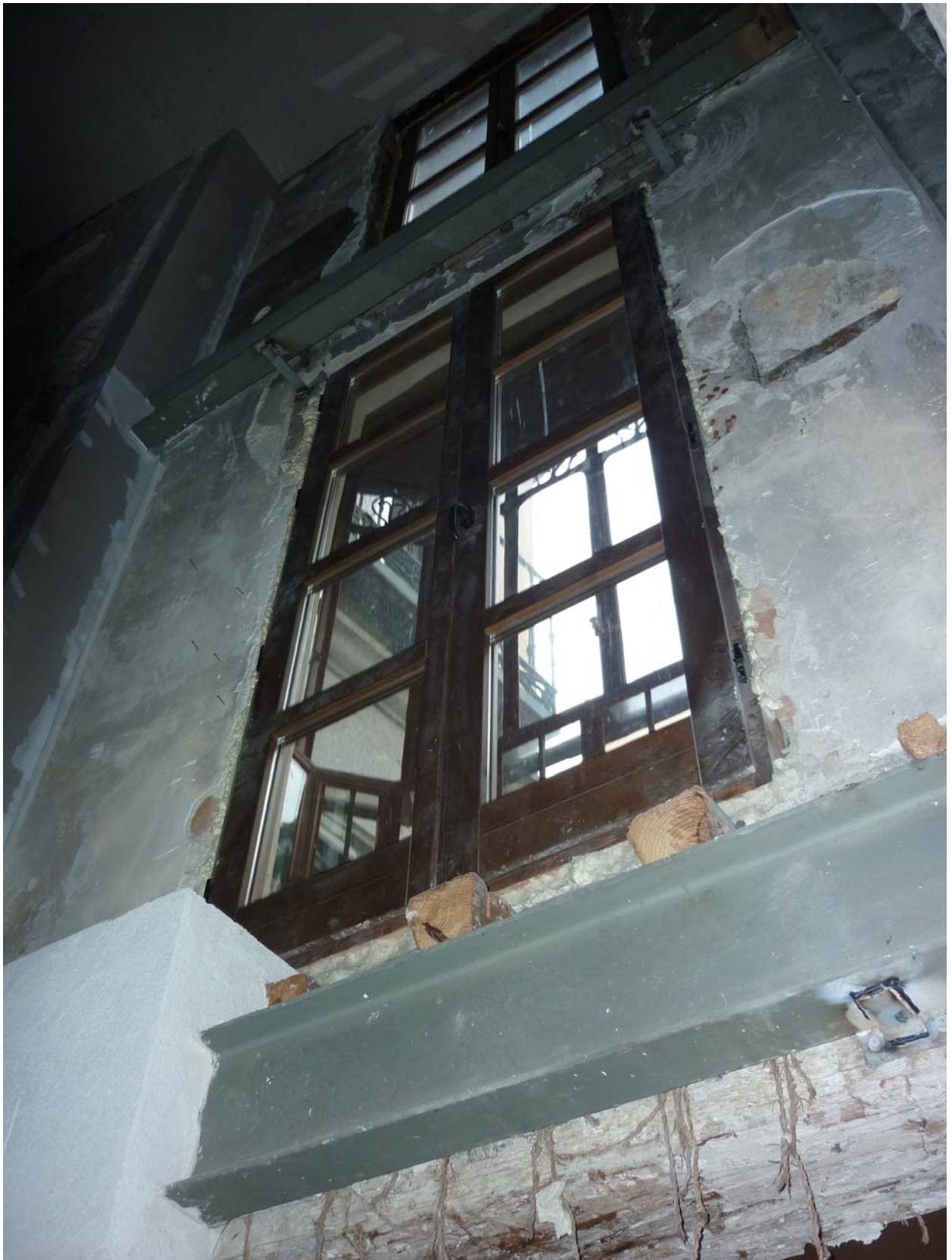
Estado actual del inmueble. Interior hacia la fachada.
