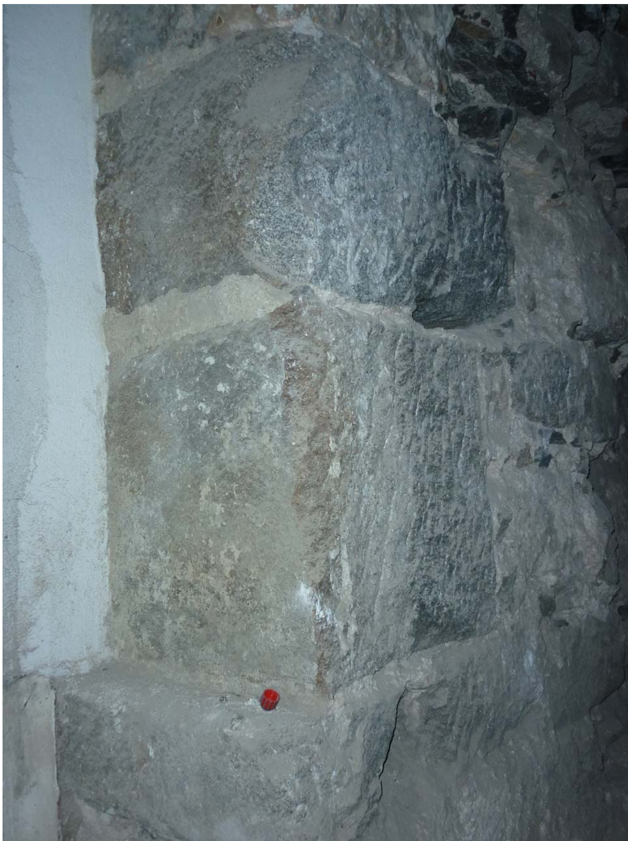
Estado actual del inmueble. Interior a la derecha. Parte inferior.
