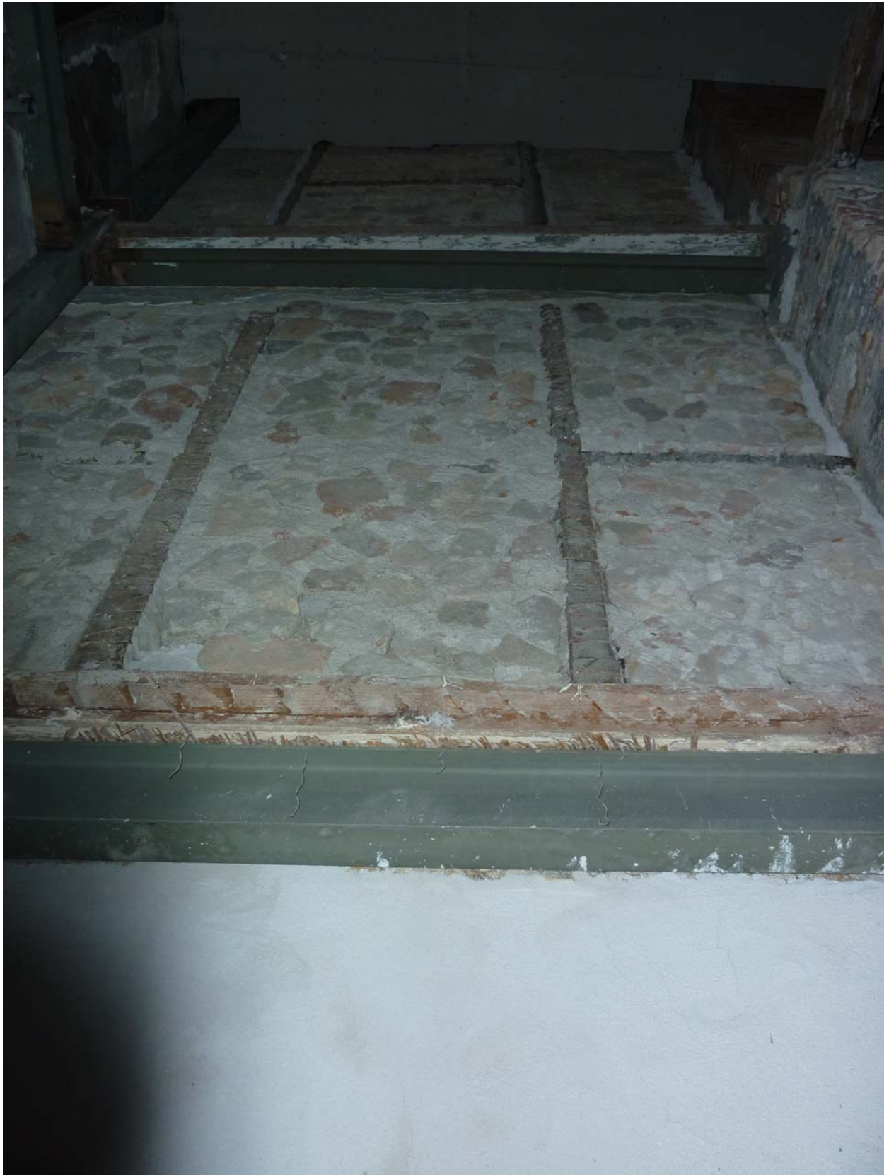
Estado actual del inmueble. Interior a la derecha. Parte superior.
