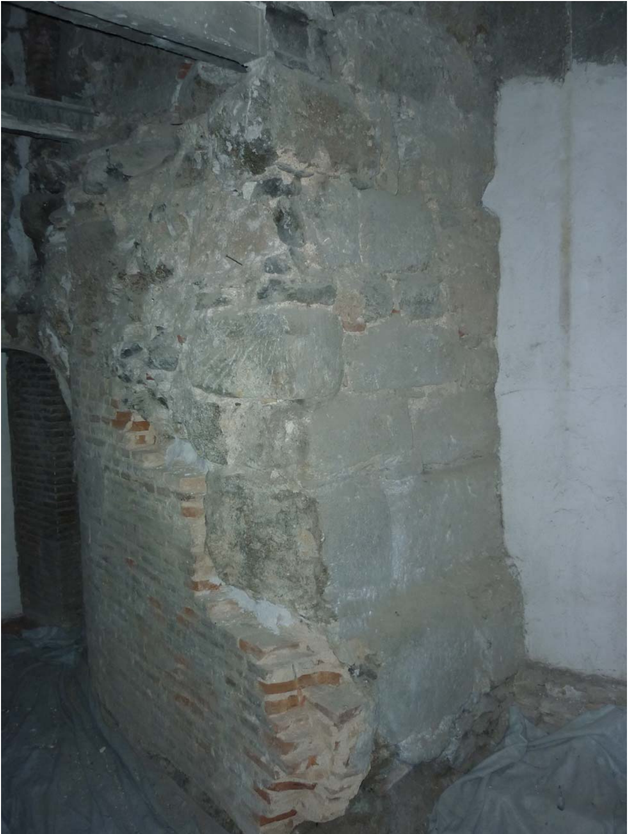
Estado actual del inmueble. Interior a la derecha.
